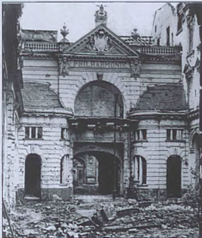
Zniszczona Filharmonia przy Bernburger Strasse, 1944 © Archiv Berliner Philharmoniker
