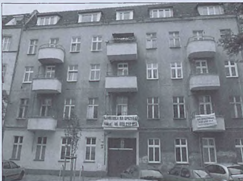
Fot 2. Kamienica przy ul. Madalińskiego (fot. J. Jachowska)
