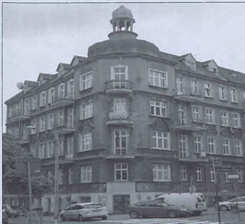
Fot. 3. Kamienica przy ul. Różanej (fot. J. Jachowska)
