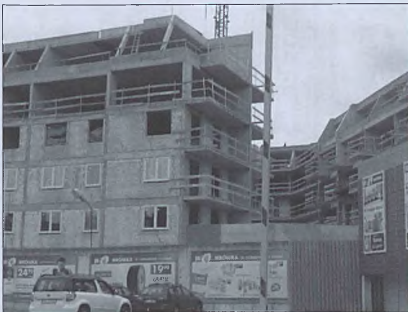
Fot. 7. Kompleks apartamentowców budowany przy ul. Przemysłowej (fot. J. Jachowska)
