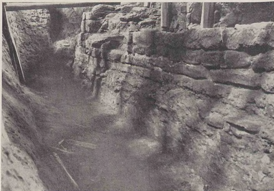
Fundament północnego muru katedry romańskiej (odkr. 1951).
