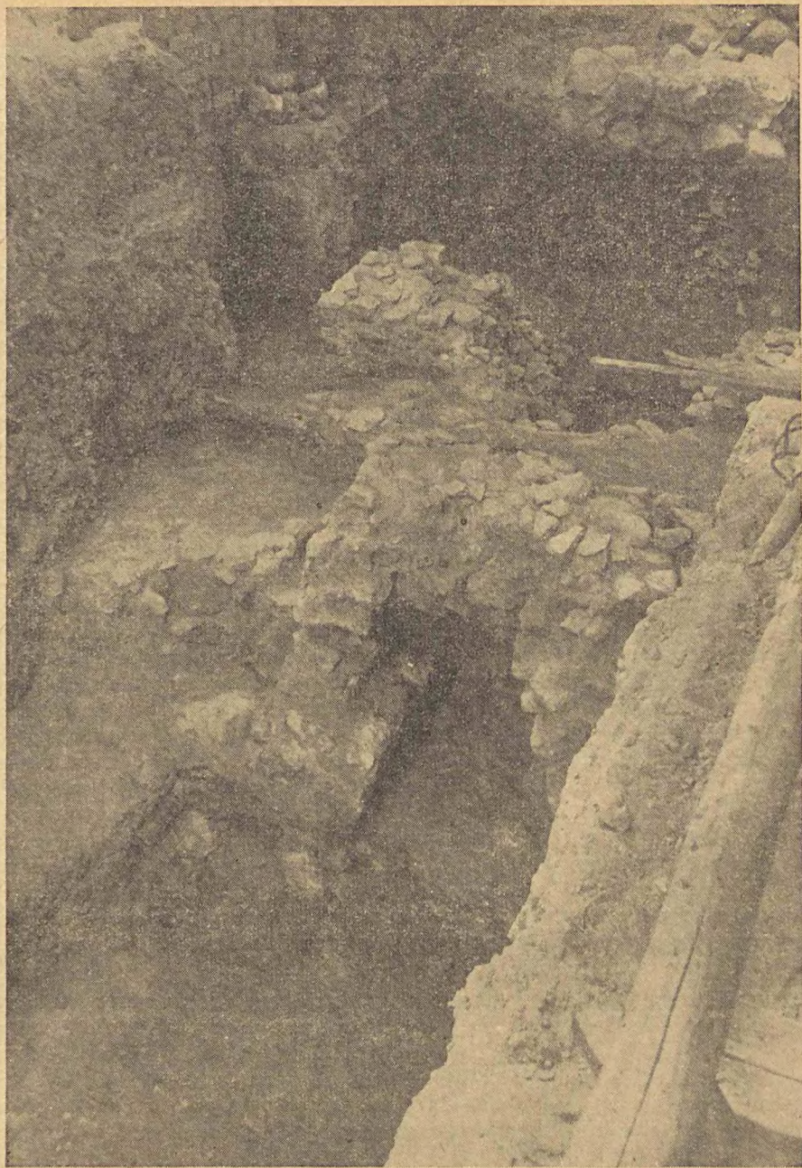
Ryc. 25. Poznań-Ostrów Tumski. Relikt grobowca preromańskiego, płyty posadzkowej i nieznannej budowli kamiennej. Widok od zachodu
