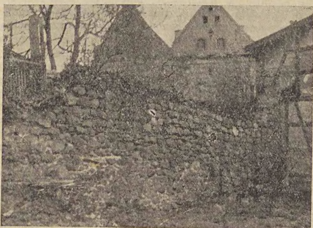
Ryc. 4. Wschowa. Fragment pd. wschodniego odcinka murów miejskich. Fot. G. Wróblewska
