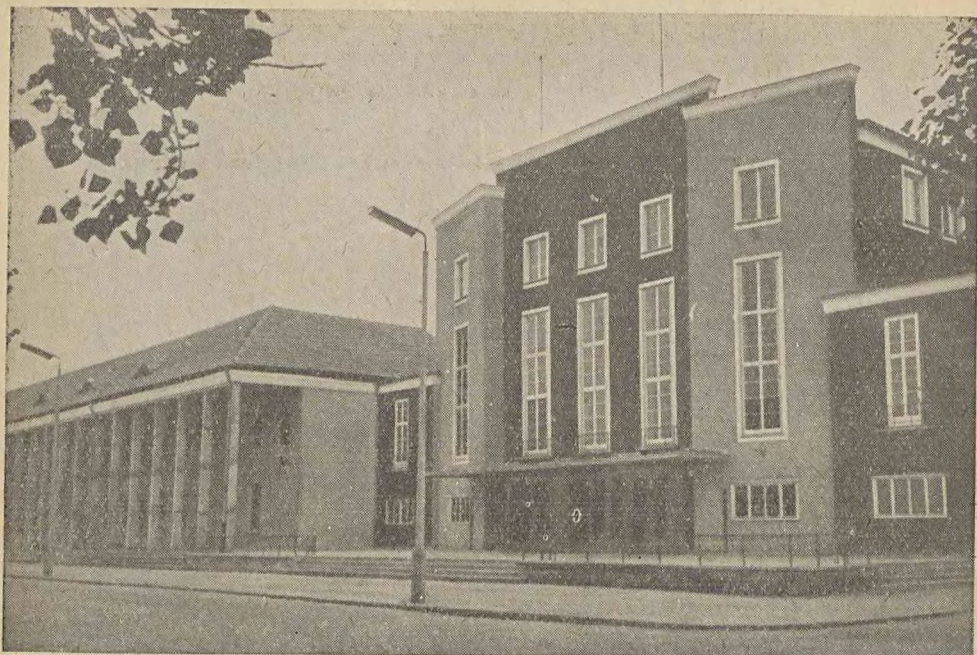
DOM KULTURY W PILE OTWARTY 2 X 1960 R.
