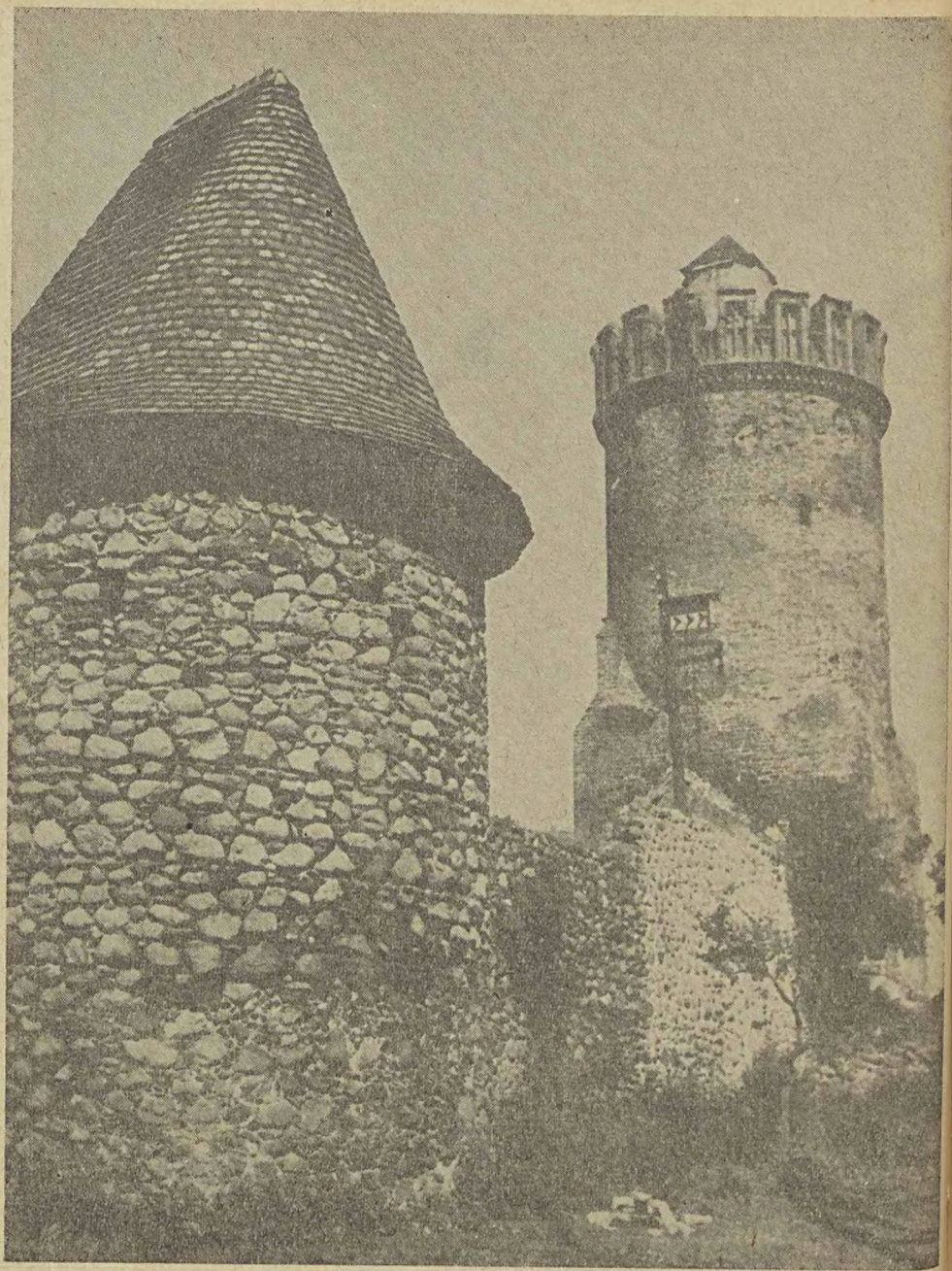
RECZ POMORSKI (POW. CHOSZCZNO) — FRAGMENT MURÓW OBRONNYCH Z PROCHOWNIĄ I BASZTĄ OBRONNĄ
