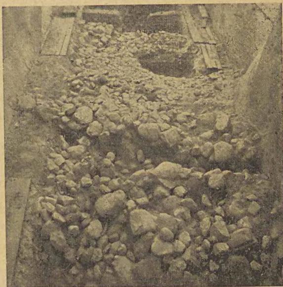
Ryc. 2. Poznań 1948 Widok ogólny ławy kamiennej. (3 faz budowy)
