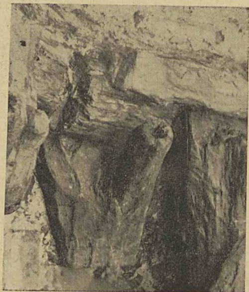
Ryc. 6. Poznań 1948. Hakowe umocnienie najmłodszej kamiennodrewnianej ławy obronnej.
