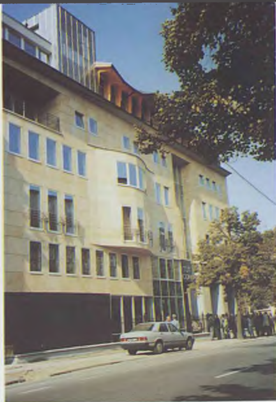
Fasada budynku Instytutu Zachodniego przy ul. Mostowej w Poznaniu
