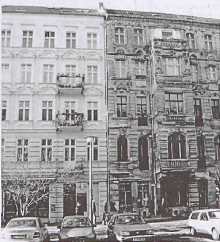
Fot. 3. Prenzlauer Berg, po prawej kamienica przed rewitalizacją
